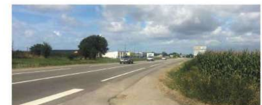
Un recul le long RD 751 permet l'insertion visuelle et paysagère des futurs volumes bâtis et une gestion raisonnée des eaux pluviales
