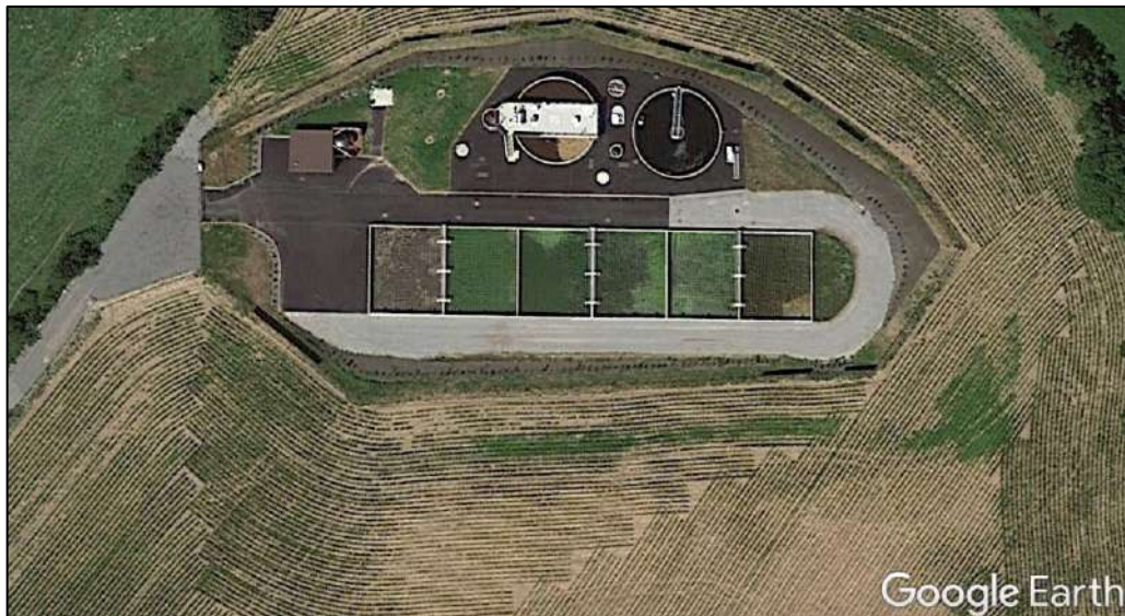
Fig. 10. La station d'épuration de la Castière
