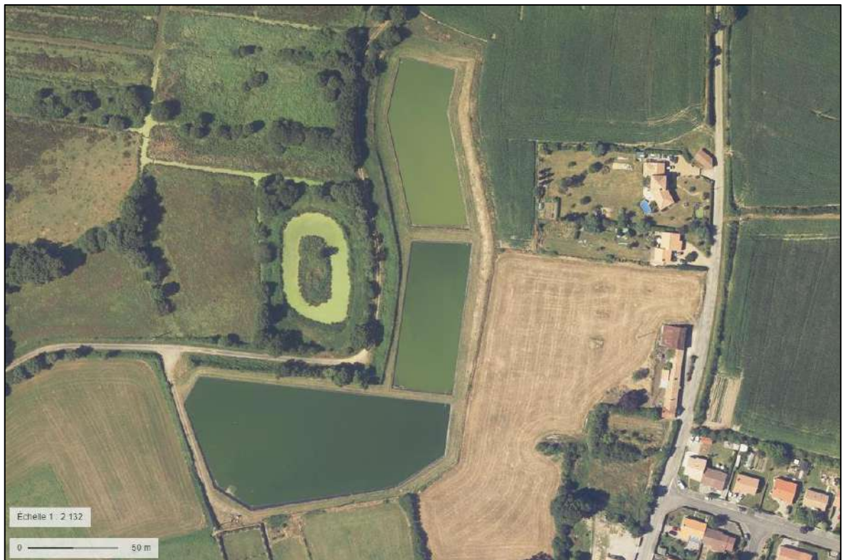
Fig. 10. La station d'épuration de Vue
