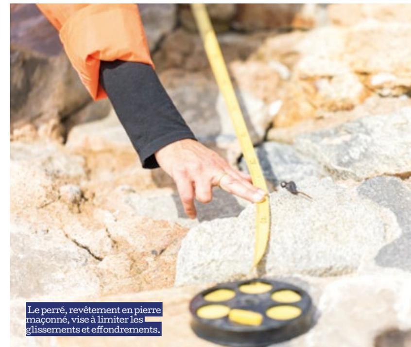
Le perré, revêtement en pierre maçonné, vise à limiter les glissements et effondrements.
