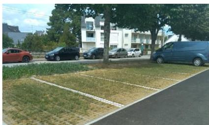
Fonction de stationnement + fonction hydraulique = parkings perméables
