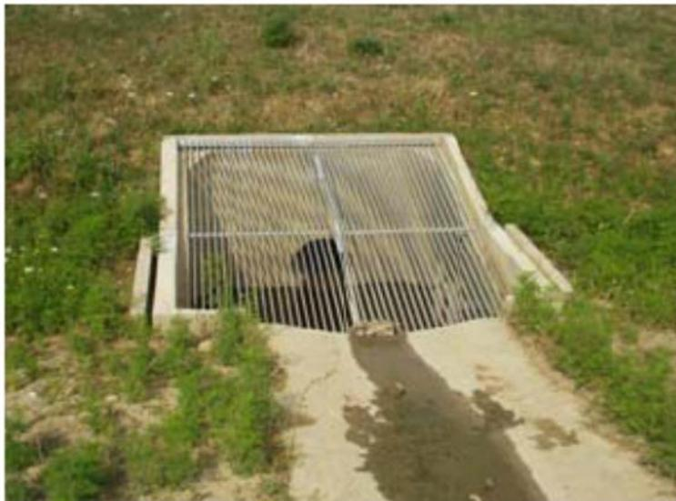
*Figure 6 : Ouvrage de sortie équipé d'une grille*
