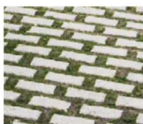
Pavage en béton avec ouvertures de drainage
