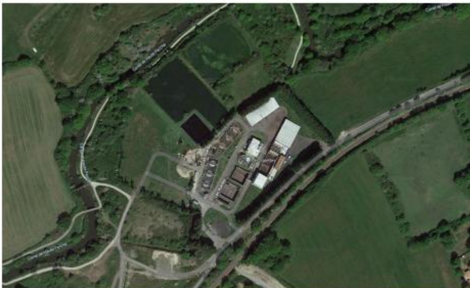
Figure 22 : Vue aérienne de la station d'épuration Les Salettes
